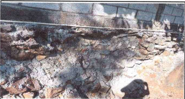
CONTENCION DE TIERRA
