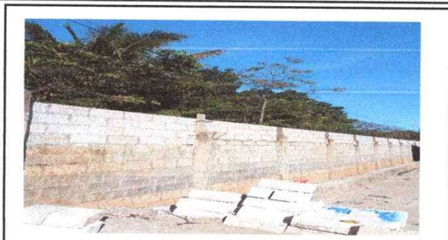
TRES HILADAS A MURO PERIMETRAL
