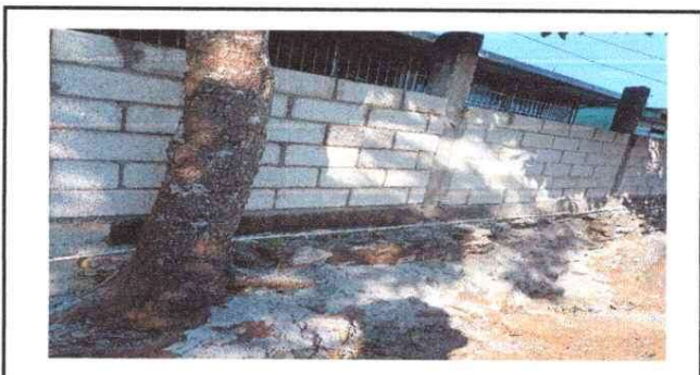
TRES HILADAS A MURO PERIMETRAL
