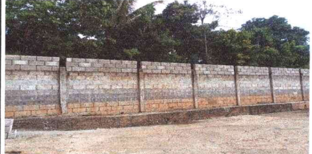
TRES HILADAS A MURO PERIMETRAL
