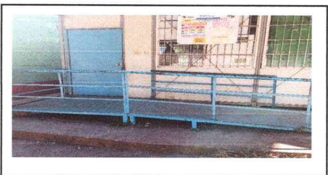
MANTENIMIENTO DE PUERTA Y BARANDA
