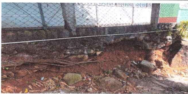
CONTENCIÓN DE TIERRA
