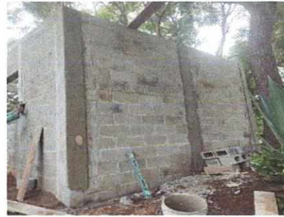
NOTA: Cisando el blok y reforzando paredes
