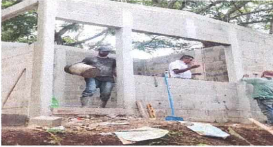
NOTA: Mejoramiento de muro de cocina y bases
