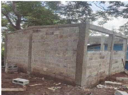
NOTA: preparando para reforzar techo
