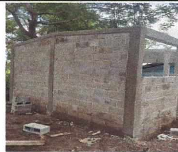
NOTA: Reforzando paredes para techo de metal.
