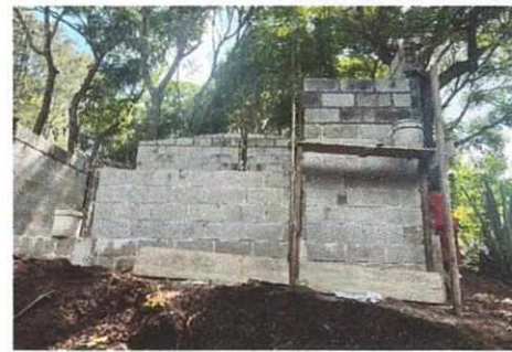
NOTA: Realizacion de gradas para acceso a la cocina
