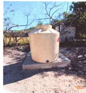
NOTA: Instalación de tubería pvc, llaves y accesorios.
