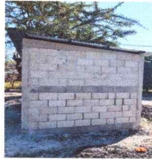
NOTA: Mejoramiento de cocina
