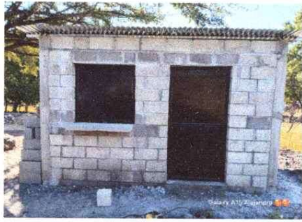
NOTA: Mejoramiento de, puertas y ventana y meseta de ventana.
