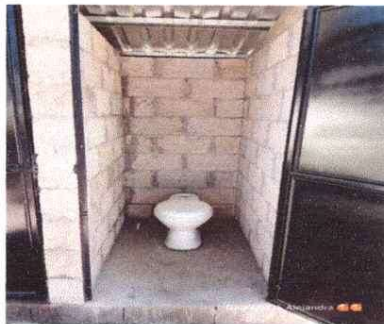
NOTA: Mejoramiento de piso en servicios sanitarios, instalación de tubería pvc y sus accesorios.
