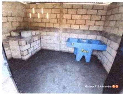
Nota: Mejoramiento de estufa rural, piso de concreto en cocina.
