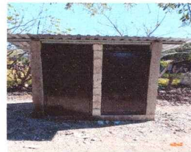
NOTA: Mejoramiento de puertas, y estructura de techo.
