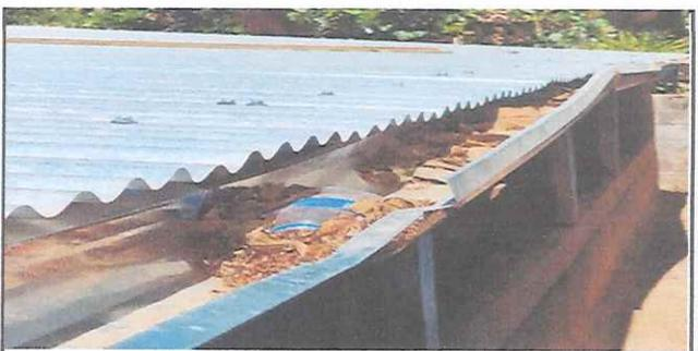
Foto 6: CANALES Y BAJADAS DE AGUA PLUVIAL
