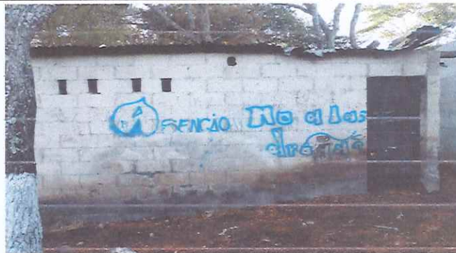
FOTO 2: Muestra la parte de atrás de la cocina actual
