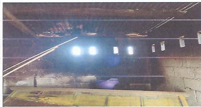
FOTO 5: Muestra la interior de la cocina actual
