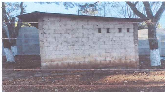
FOTO 4: Muestra la parte posterior derecha de la cocina actual
