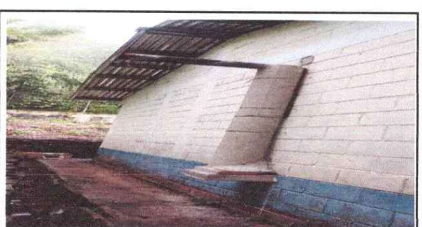
sustitucion de la chimenea
