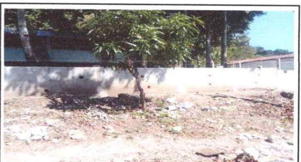
Construcción del muro de contención
