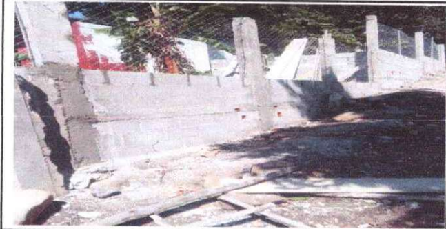
NOTA construcción de muro perimetral.
