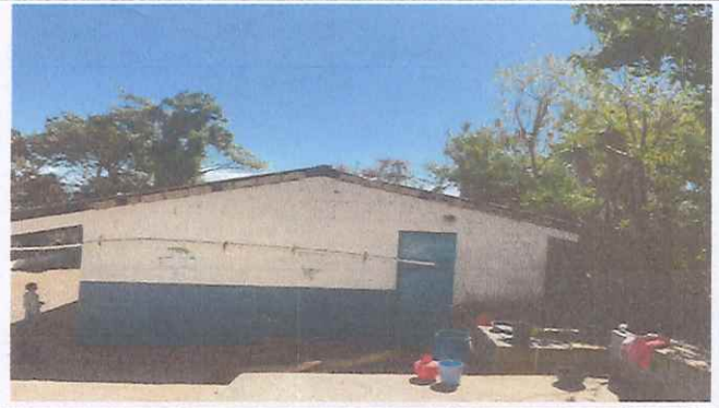
Foto 2: Cambio de puerta y relleno de block, Dirección.
