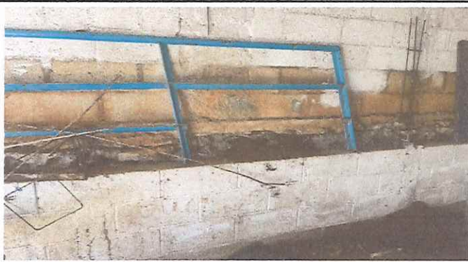
Foto 3: Reparación de pared y función de plancha para cocina.
