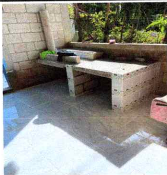
Finalización de colocación de piso cerámico
