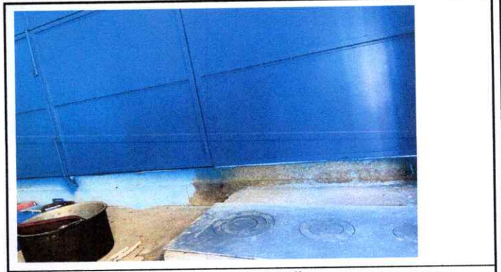
Finalización de instalación de plancha metálica
