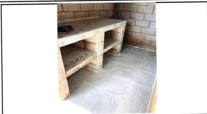
Finalización de reparación de cocina
