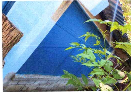
Finalización de instalación de ventanas de cocina y dirección
