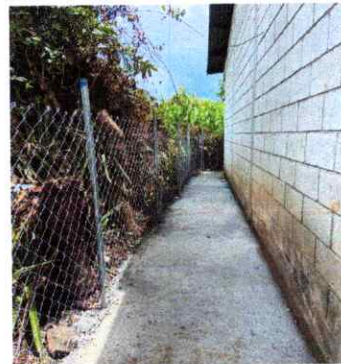
Finalización muro perimetral
