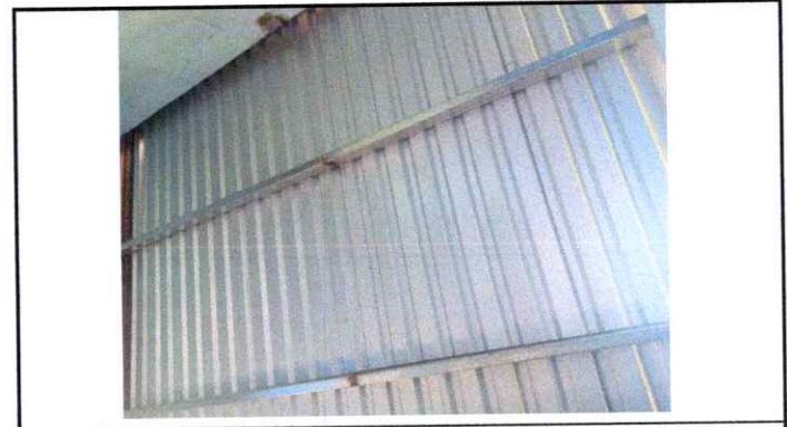
Finalización de estructura de soporte de madera por metal
