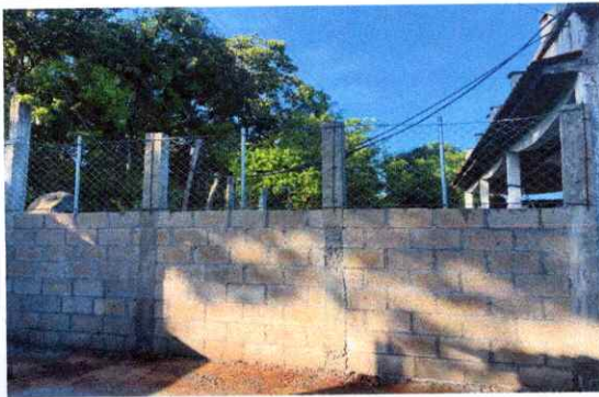
Finalización muro perimetral a un costado de la escuela
