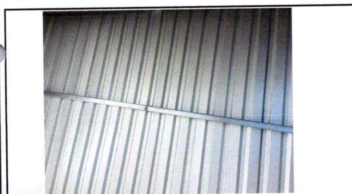
Finalización de instalación de lamina troquelada aluzing calibre 26
