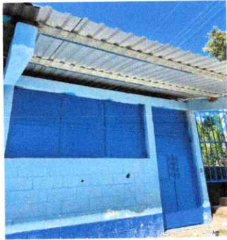
Finalización de puertas de dirección
