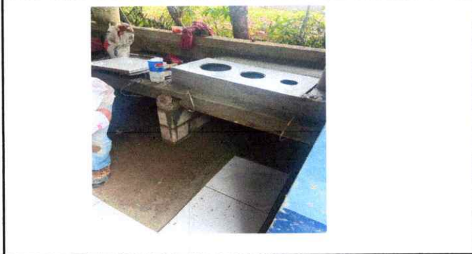
En proceso de instalación de plancha metalica con chimenea
