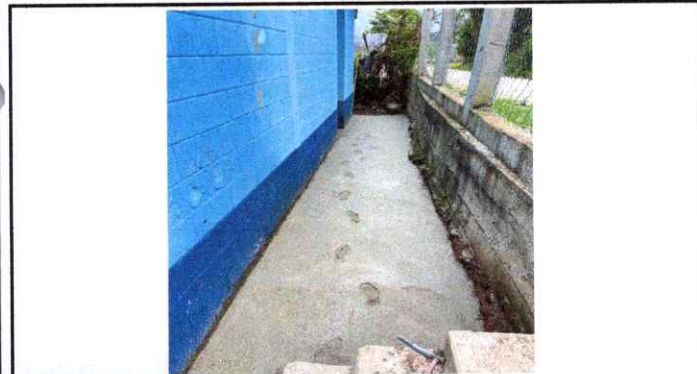
En proceso de aplicación de torta de concreto
