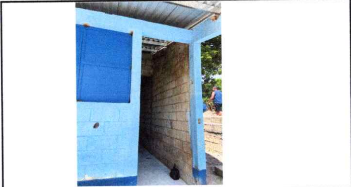
En proceso de instalación de puertas en dirección
