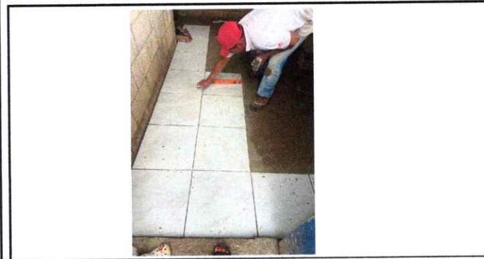
Proceso de colocación de piso ceramico
