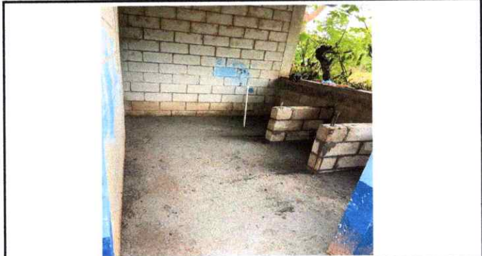
En proceso de reparación de cocina
