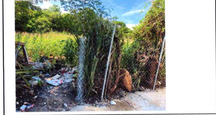
Proceso de reparación muro perimetral
