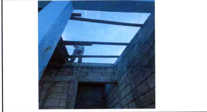
En proceso de sustitución de soporte de madera por metal
