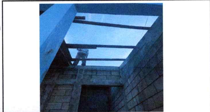
En proceso de colocación de lamina troquelada alucing calibre 26
