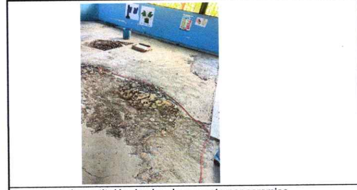
En proceso de sustitución de piso de concreto por ceramico
