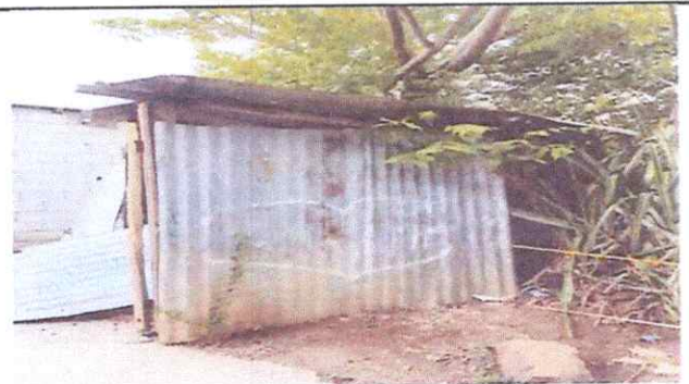
Reparación de servicios sanitarios
