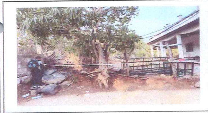
Muro Perimetral a un costado de la escuela
