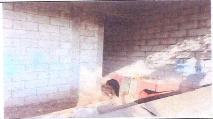
Reparación de cocina
