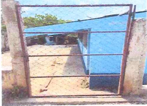
Sustitución de porton de metal
