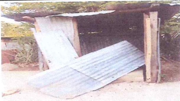
Reparación de servicios sanitarios
