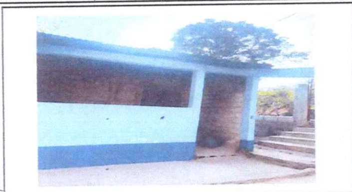
Instalación de puertas de dirección
