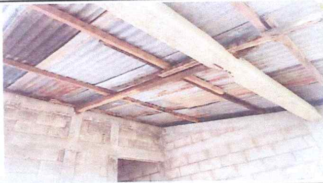
Sustitución de lámina troquelada aluzing calibre 26
