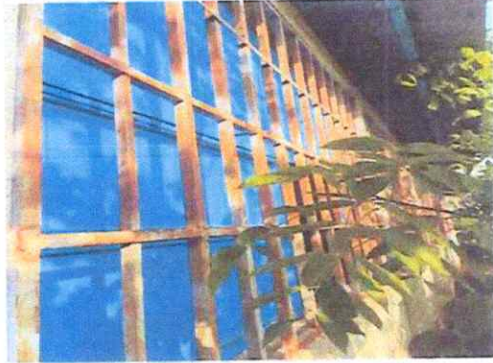
Mantenimiento de barandas
