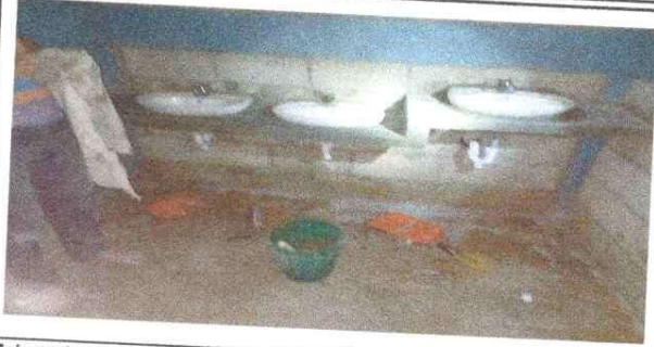
Mejoramiento de Sanitarios
