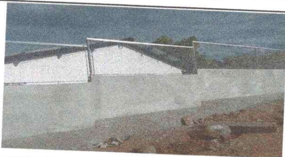
Mejoramiento muro perimetra
