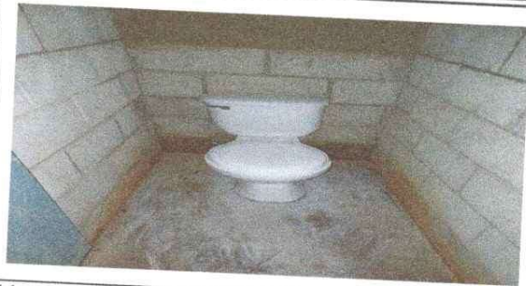
Mejoramiento de Sanitarios
