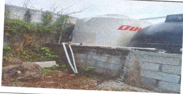
Mejoramiento de Sanitarios
