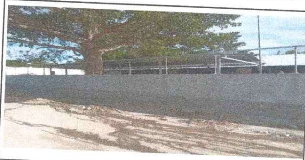
Mejoramiento muro perimetral
