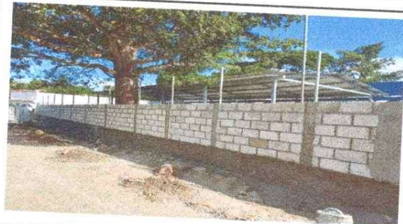
Mejoramiento muro perimetral
