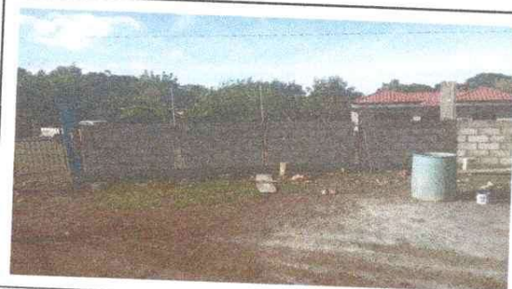
Mejoramiento muro perimetral
