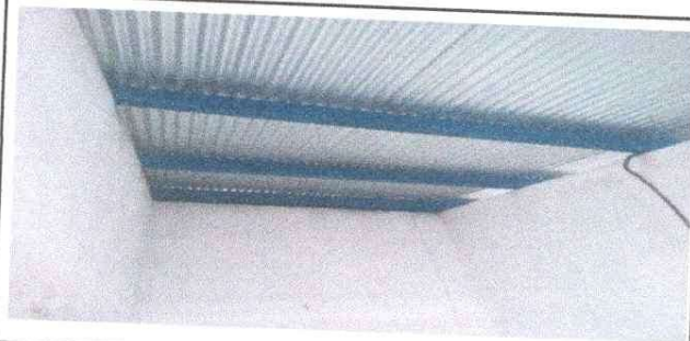
Mejoramiento de Sistema Eléctrico
