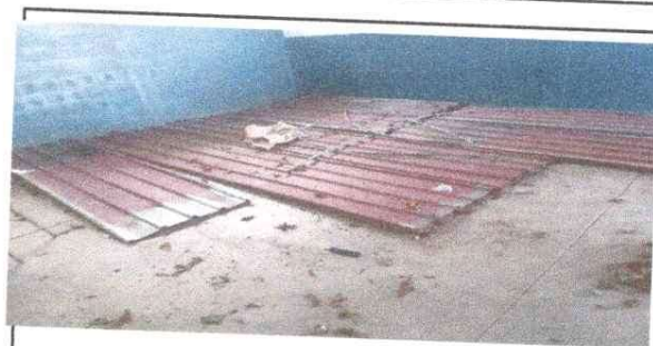
Mejoramiento de Sistema Eléctrico
