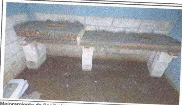
Mejoramiento de Sanitarios
