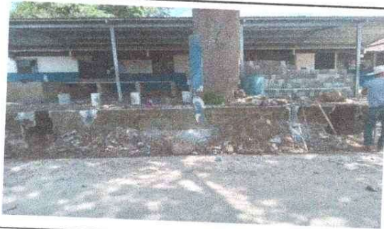
Mejoramiento muro perimetral
