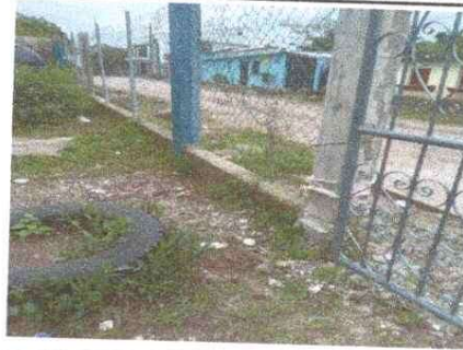
Mejoramiento muro perimetral
