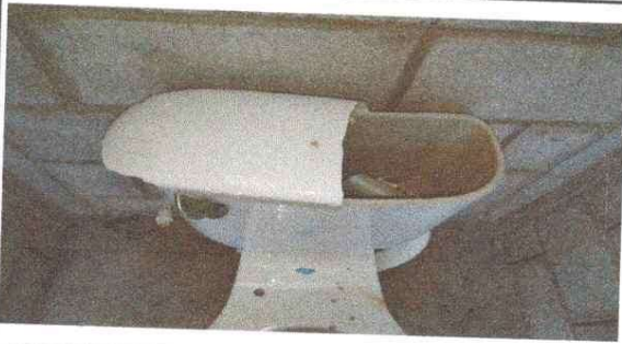
Mejoramiento de Sanitarios
