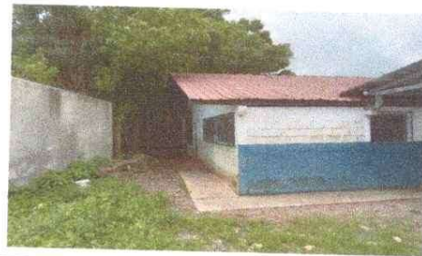
Mejoramiento de Techos No. 2
