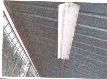
Mejoramiento de Sistema Eléctrico
