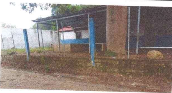
Mejoramiento muro perimetral
