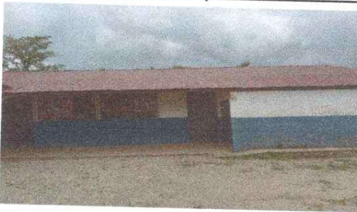
Mejoramiento de Techos No. 1
