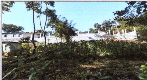
FOTOGRAFIA EN UNA SOLA TOMA 36 METROS DE MURO TERMINADO.
