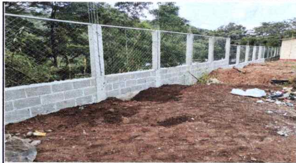
FOTOGRAFIA DESDE LA PARTE TRASERA DE LOS SERVICIOS SANITARIOS YA TERMINADO.
