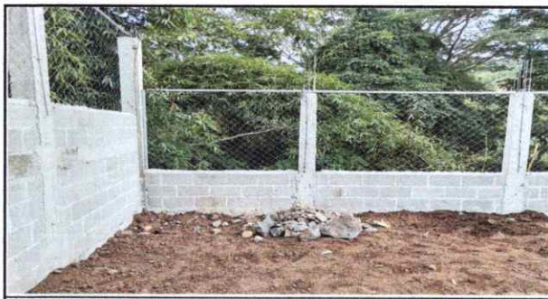
FOTOGRAFIA TOMADA ENTRE LOS SERVICIOS SANITARIOS TERMINADO
