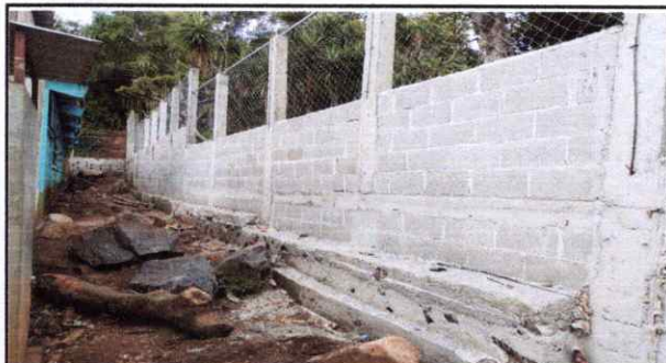
FOTOGRAFIA DESDE LA PARTE TRASERA DEL ESTABLECIMIENTO TERMINADA.
