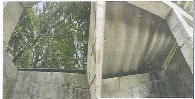
SUSTITUCION DE LAMINA POR LAMINA TROQUELADA ALUZINC CAL 26
