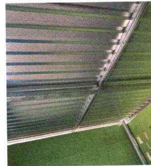
NOTA: se colocaron vigas de metal y lamina.
