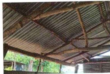
Foto 4: La estructura del techo es de vigas de madera, las cuales ya estan en mal estado.
