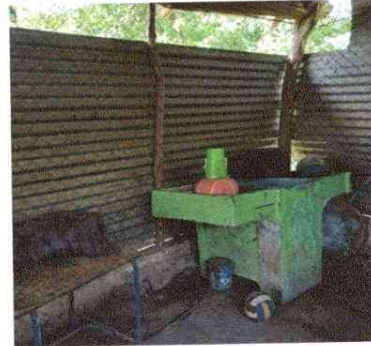
Foto 2: La pila esta en mal estado, no se puede guardar agua.
