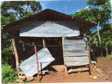
Foto 1: Condiciones de la cocina.
