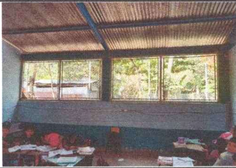
Instalación de ventana-balcon
