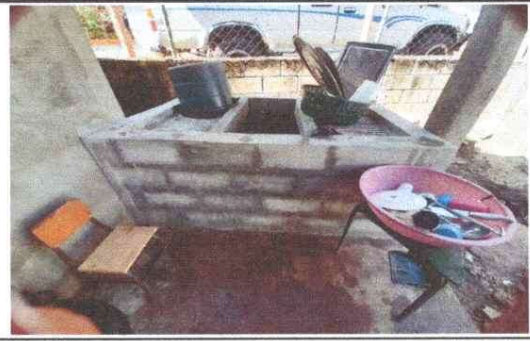
Sustitución por pila de cemento dos lavaderos para la cocina
