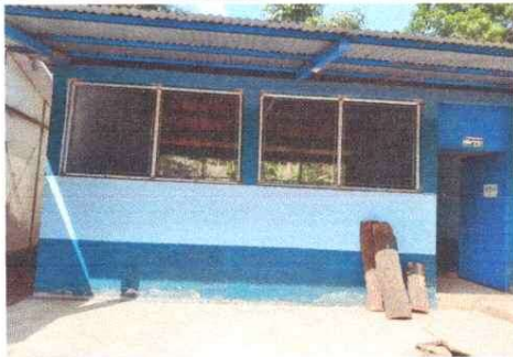
Instalación de ventana-balcon
