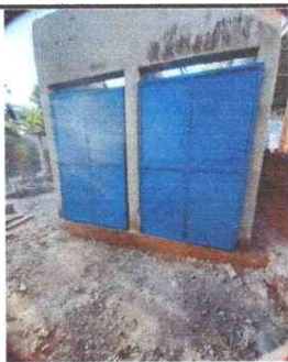
Sustitución de puerta de sanitarios
