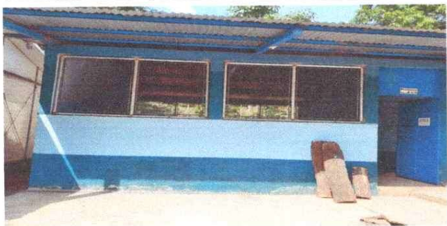
Instalación de ventana-balcon
