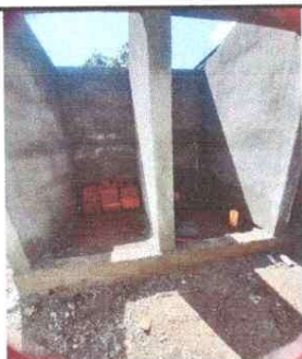
Sustitución de puerta de sanitarios
