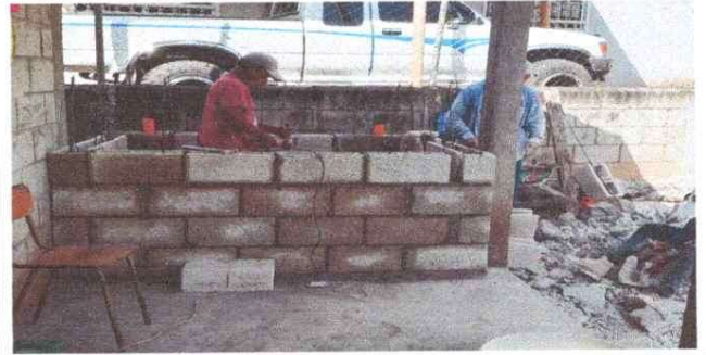
Sustitución por pila de cemento dos lavaderos para la cocina
