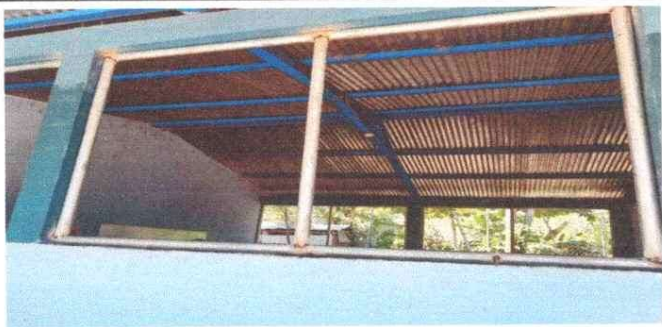
Instalación de ventana-balcon
