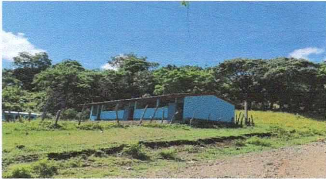
techo de cocina y escuela entera
