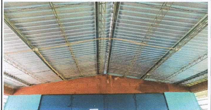
techo de aulas
