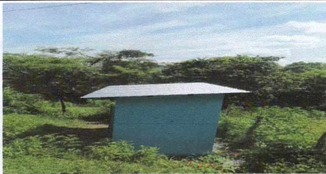
techo de cocina
