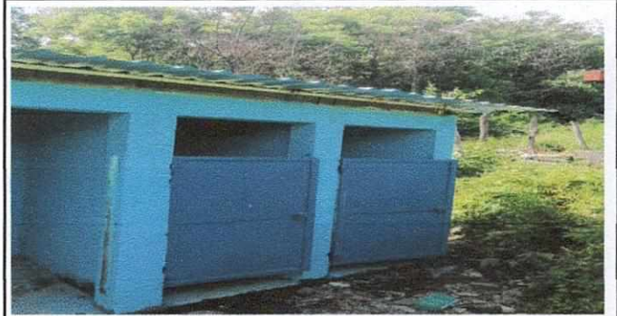
puertas de baños
