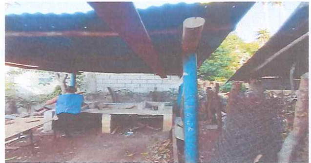
foto 6: muestra la parte derecha de la cocina
