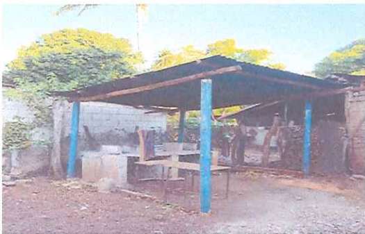
foto 5: muestra la parte izquierda de la cocina
