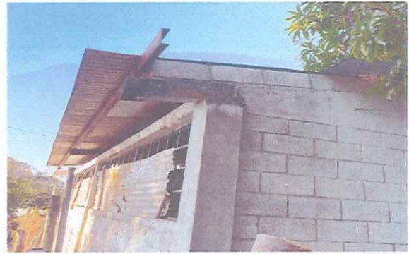
foto 2. muestra la parte de afuera del techo
