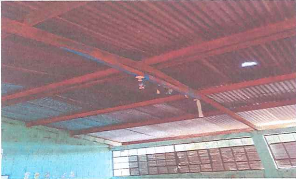
foto 1. muestra la parte de adentro del techo.
