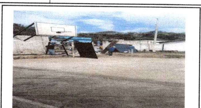
Reparación e Insalación de Porton
