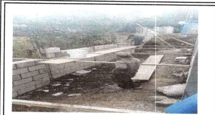
Reparación de Muro Perimetral
