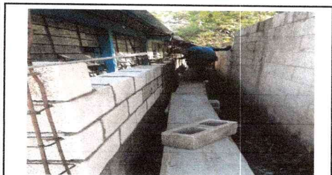
Reparación de Muro perimetral
