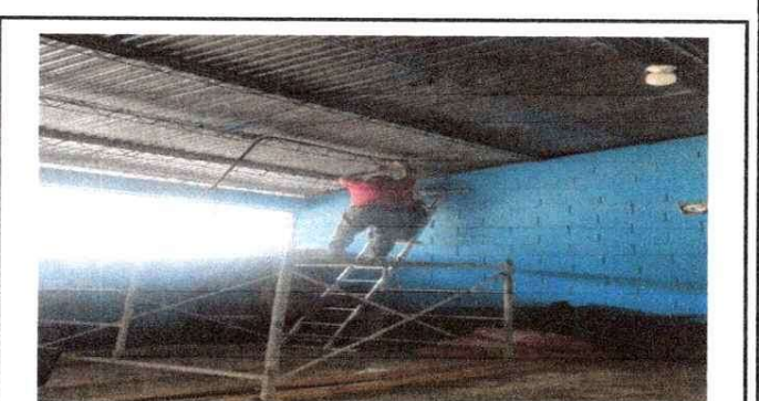
Reparación de lamparas
