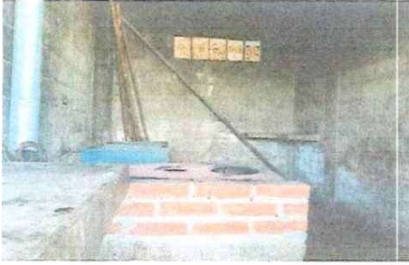
mejoramiento de paredes de cocina
