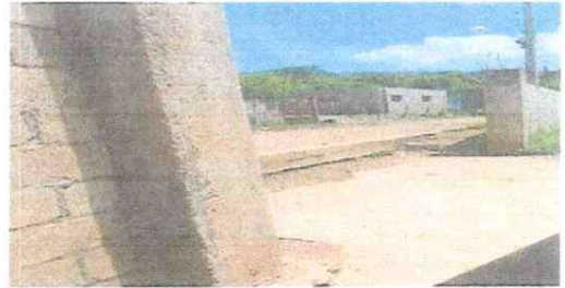
Sustitucion de Portón
