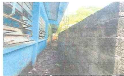
Colocacion de Balcones
