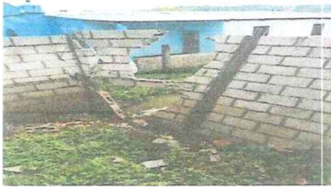
Mejoramiento de Muro Perimetral
