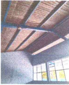
PINTURA DE ESTRUCTURA METÁLICA
