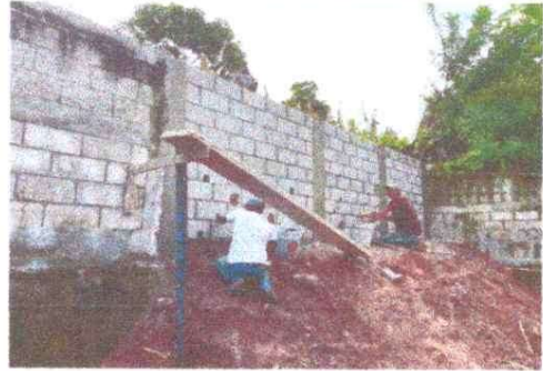
MEJORAMIENTO DE MURO DE CONTENCIÓN
