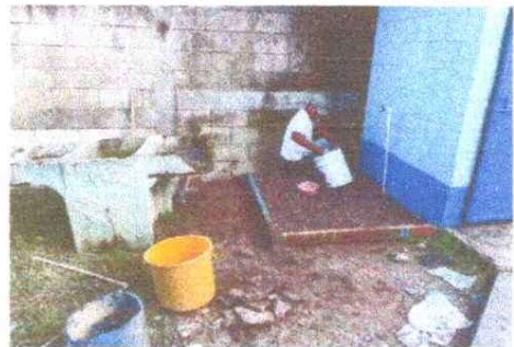
INSTALACIÓN DE PILA DE CEMENTO
