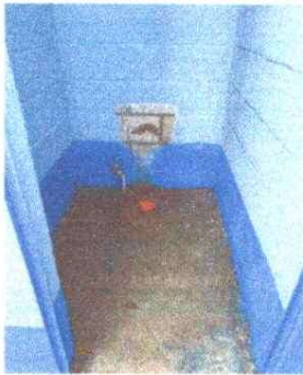
SUSTITUCIÓN DE SANITARIOS Y ACCESORIOS
