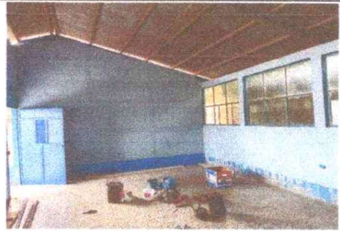
PINTURA DE AULAS INTERIOR Y EXTERIOR
