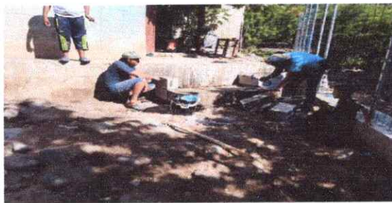
Proceso de reconstrucción de las gradas de acceso al patio trasero.
