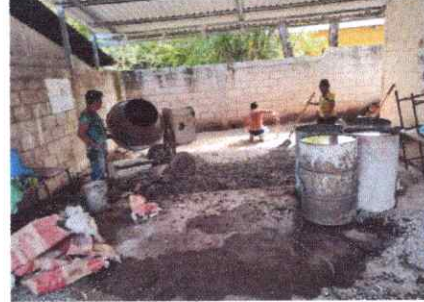
Proceso de fundición de la torta de concreto del patio trasero.
