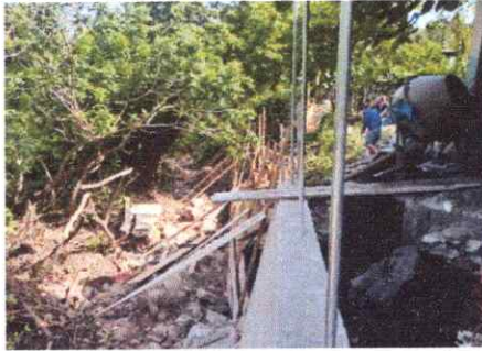
Parte de la construcción del muro de contención
