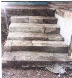
Demolición y reconstrucción de gradas traseras.
