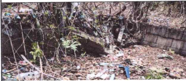
Mejoramiento del muro de contención
