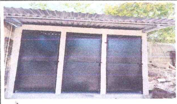
AMPLIACIÓN DE BAÑOS
