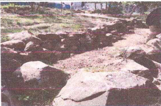
MANTENIMIENTO DE MURO DE CONTENCIÓN CON CONCRETO CICLÓPEO
