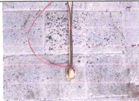
INSTALACIÓN DE ENERGÍA ELÉCTRICA
