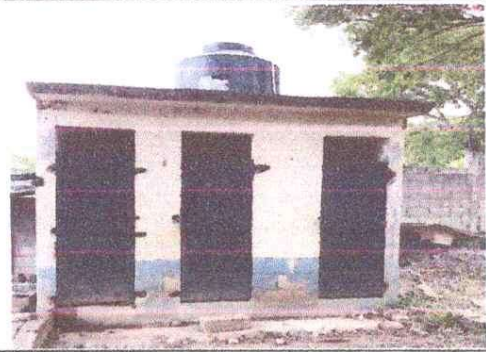
AMPLIACIÓN DE BAÑOS
