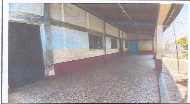
Mantenimiento de pintura general y colocación de ventanas.
