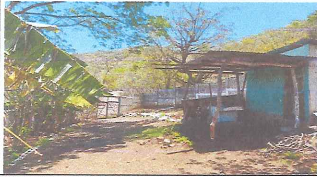
Mejoramiento de cocina, estructura techo y lamina, piso ceramico, entortado y pila nueva.
