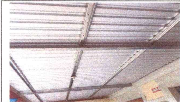
FINALIZACIÓN DE ESTRUCTURA METÁLICA Y LÁMINA TROQUELADA
