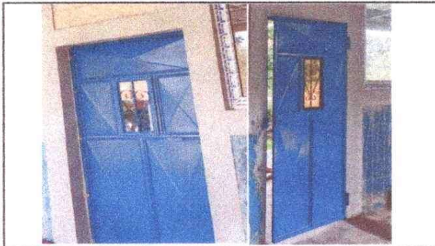
COLOCACIÓN DE PUERTAS
