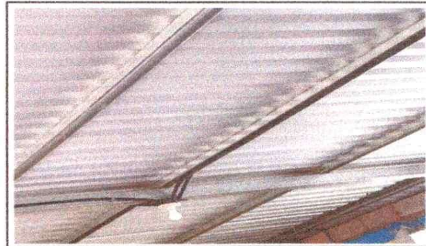
INSTALACIÓN DE ENERGÍA ELÉCTRICA
