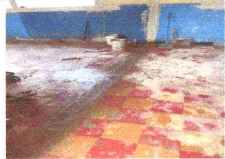
DEMOLICIÓN DE PARED EN AULA
