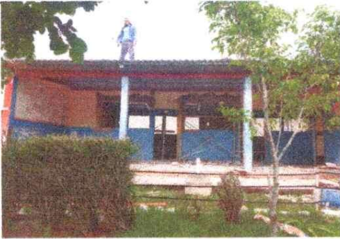
COLOCACIÓN DE LÁMINA TROQUELADA
