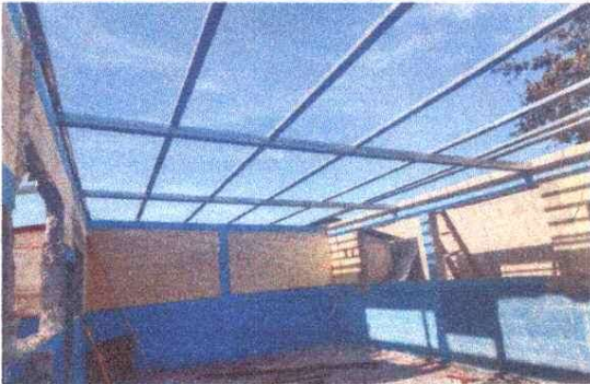
COLOCACIÓN DE ESTRUCTURA METÁLICA
