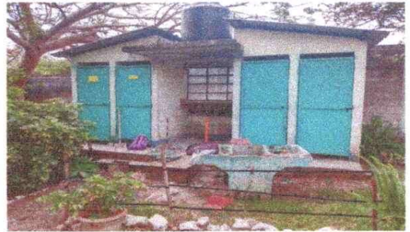
MANTENIMIENTO DE PILA
