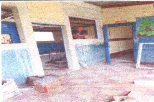
INSTALACIÓN DE VENTANAS PVC
