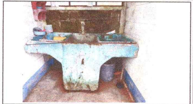
MANTENIMIENTO DE PILA
