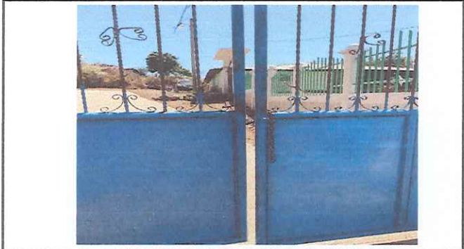
PORTÓN: Se necesita instalación de pasador y seguro de metal.
