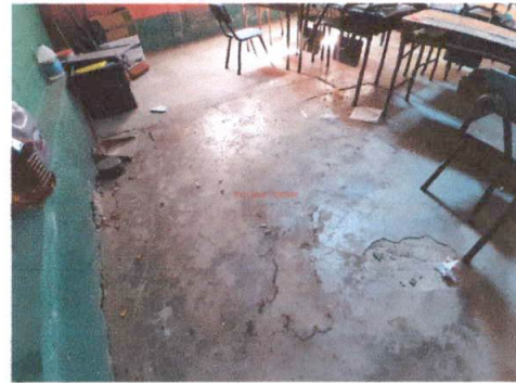
Foto 4: Piso interior de aulas
