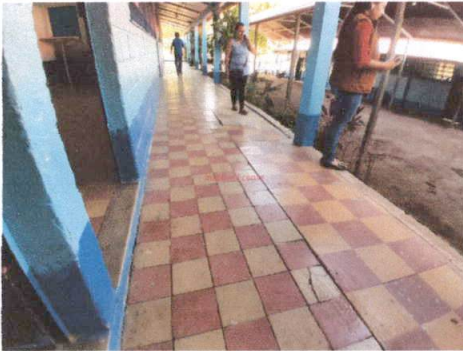
Foto 3: Piso de pasillos
