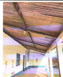
Foto 5: Área de aulas se pintara la estructura metálica y lamina de color gris anticorrosivo.
