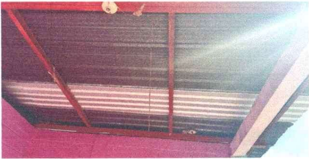
CAMBIO DE LAMINAS EN MAL ESTADO
