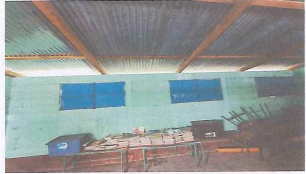
FOTO 8. ESPACIO ENTRE EL TECHO Y LA PARED DEL LADO IZQUIERDO DE UNA AULA SE NECESITA EL CERRAMIENTO CON BLOK
