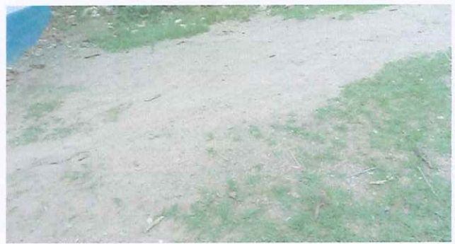
FOTO 2. REMOZAMIENTO DE TUBERIA DE DRENAJE PARA AGUA PLUVIAL
