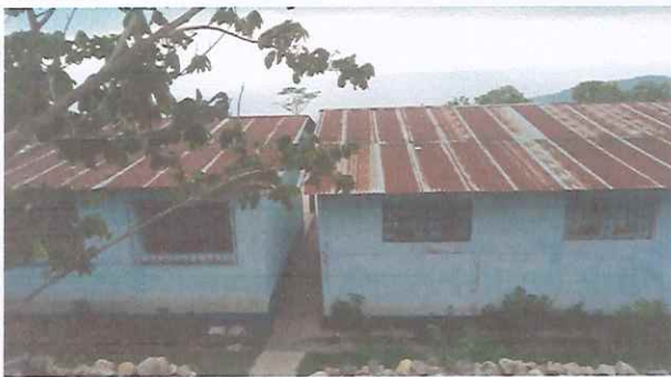
FOTO 5. TECHO EN MAL ESTADO, SE SUSTITUIRA EL TECHO COMPLETO DE 2 AULAS Y 1 BODEGA
