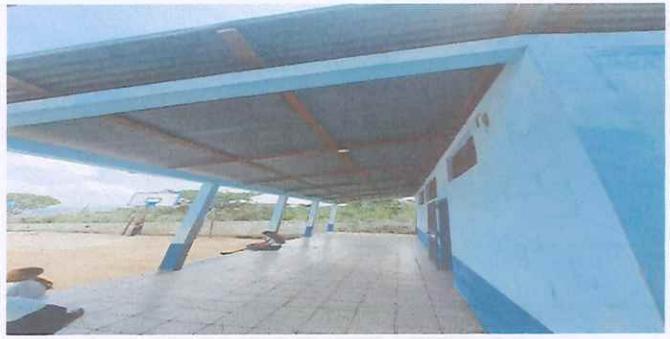
FOTO 6. ESTRUCTURA DE MADERA EN MAL ESTADO, SE SUSTITUIRA POR ESTRUCTURA DE METAL DE LA BODEGA Y 1 AULA
