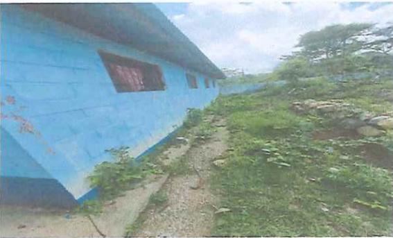
FOTO 3. REMOZAMIENTO DE CUNETAS EN LA PARTE DE ATRÁS DE LAS AULAS
