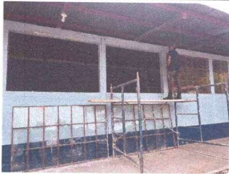
DURANTE REMOSAMIENTO DE VENTANAS DE PVC
