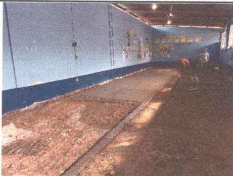
DURANTE INSTALACION DE PISO CERAMICO
