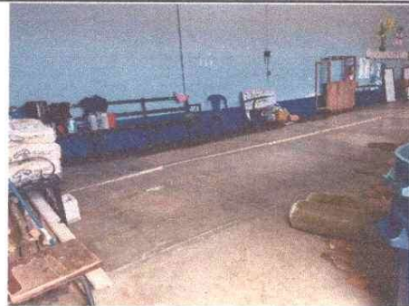
REMOSAMIENTO DE TORTA DE CEMENTO
