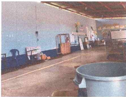
INSTALACION DE PISO CERAMICO
