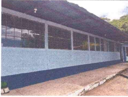
REMOSAMIENTO DE VENTANAS DE PVC
