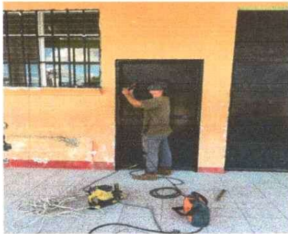
REMOSAMIENTO DE PUERTA BALCÓN DURANTE
