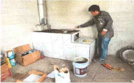
REMOSAMIENTO DE PISO CERÁMICO DURANTE
