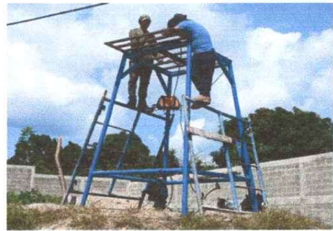
SUSTITUCION BASE DE TINACO DURANTE
