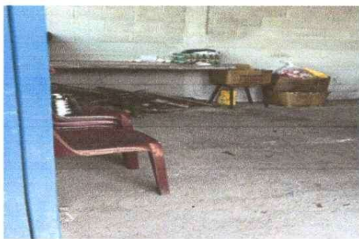
REMOSAMIENTO DE PISO PREVIO
