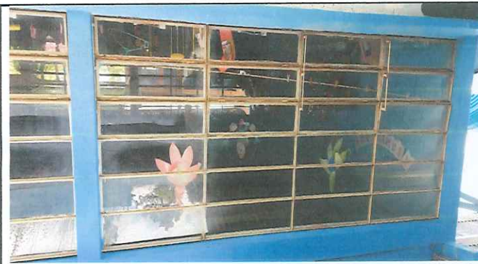
CAMBIO DE VENTANAS
