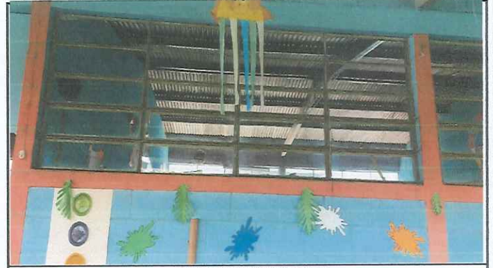
CAMBIO DE VENTANAS
