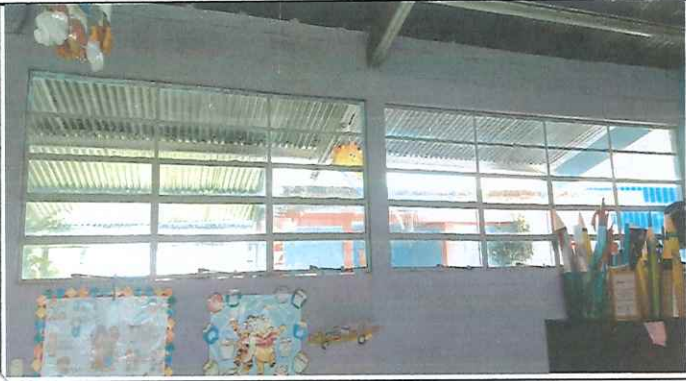
CAMBIO DE VENTANAS
