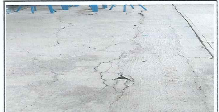
TORTA DE CEMENTO DEL PATIO EN MAL ESTADO
