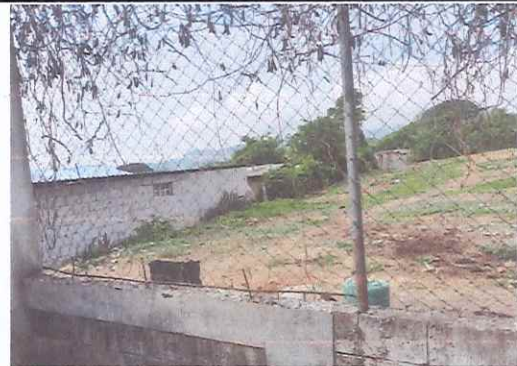
MURO, CONTINUACIÓN DE MURO PERIMETRAL
