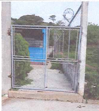
PORTÓN, SUSTITUCIÓN DE PORTÓN PRINCIPAL
