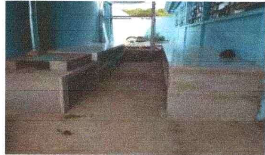
MEJORAMIENTO CONTRAPISO FUNDIDO
