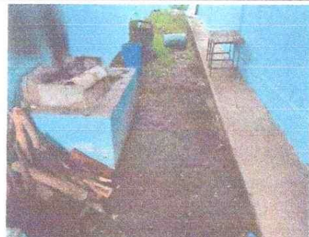
Foto 2: MEJORAMIENTO CONTRAPISO FUNDIDO
