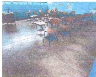
Foto 6: INSTALACION PISO AULA 2
