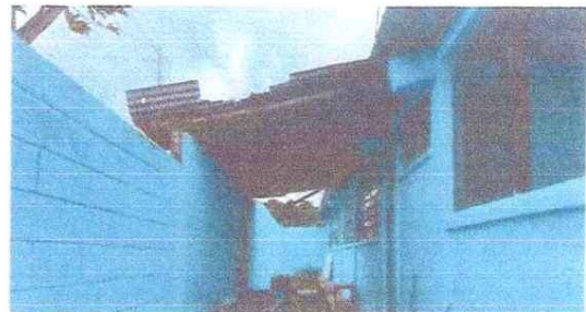
Foto 4: SUSTITUCION CUBIERTA DE LÁMINA TROQUELADA CALIBRE 26
