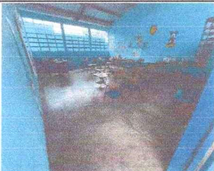
Foto 5: INSTALACION PISO AULA 1
