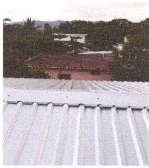
2.1 AULAS: Cambio de techo de dos aulas con lámina troquelada.
