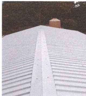
2.1 AULAS: Cambio de techo de dos aulas con lámina troquelada.
