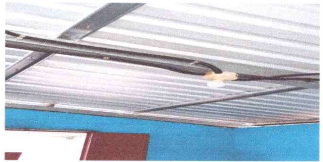
1.2 COCINA Remozamiento de techo e instalación de estructura metálica y lámina troquelada
