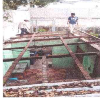
1.2 COCINA: Cambio de techo de cocina.
