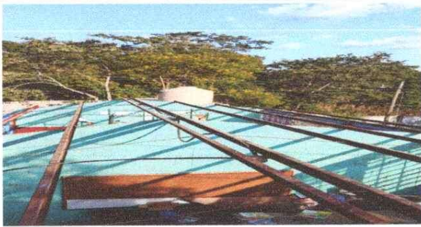
2.1 AULAS: Cambiando de techo dos aulas.
