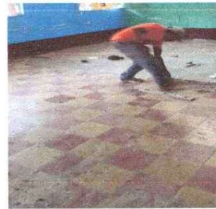
2.2 Poniendo piso de tres aulas
