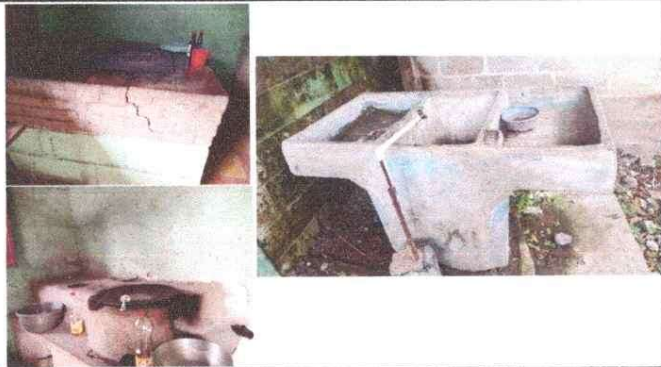
1.1 COCINA, Remodelación de cocina con dos planchas con chimenea, una pila, tinaco y un pasamano
