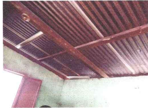
1.2 COCINA, Remozamiento de techo e instalación de estructura metálica y lámina troquelada
