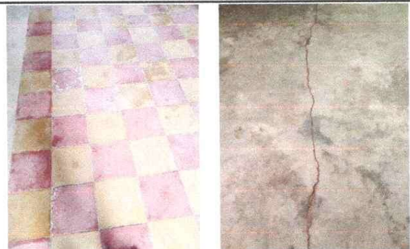
2.2 AULAS, Instalación de Piso Cerámico
