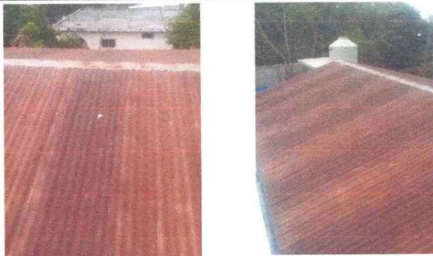
2.1 AULAS, Cambio de techo a dos aulas
