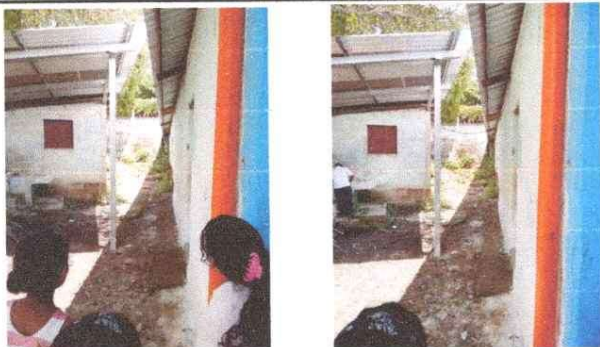
3 ÁREA ALEDAÑA A COCINA: Entortado de concreto
