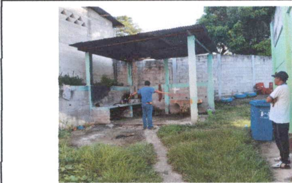
Foto 3: Medición en área de cocina
