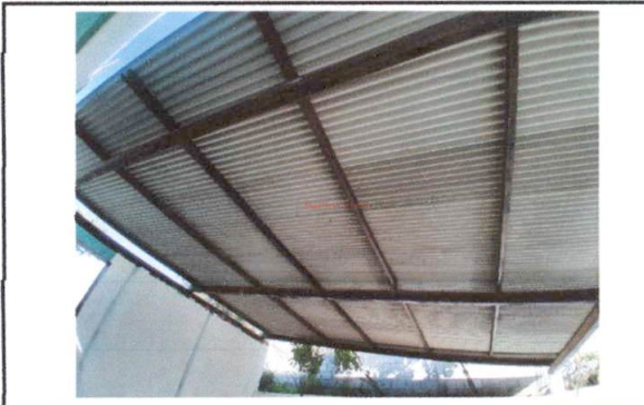
Foto 6: Cubierta área de comedor
